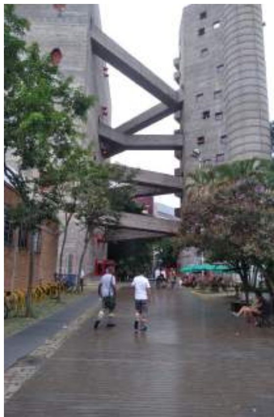
Figura 2 – Blocos de concreto da área esportiva.
